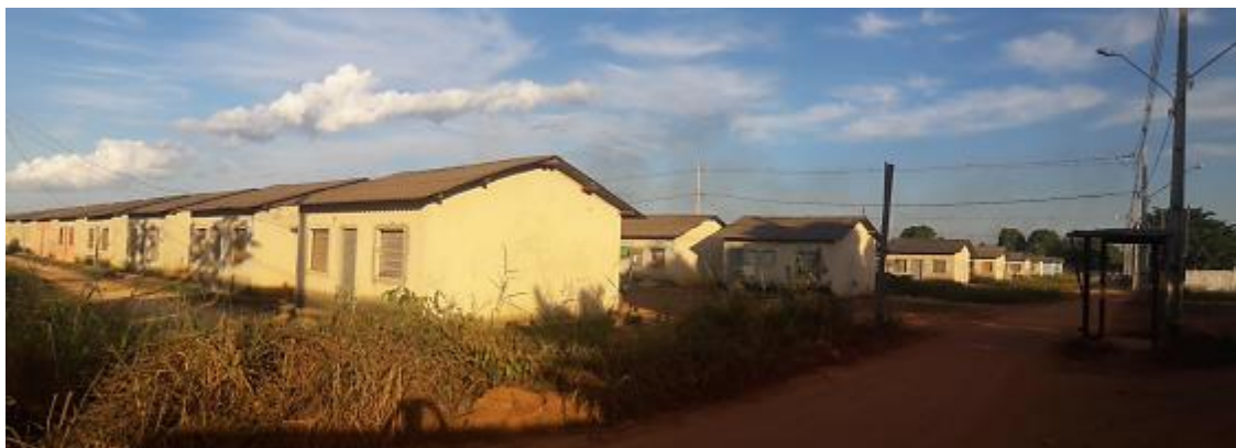
Figura 89 - Conjunto habitacional do FNHIS com obra paralisada. (IBAM, 2018)
