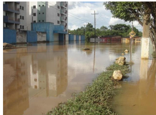
Figura 36 - Via pública atingida pela inundação.
