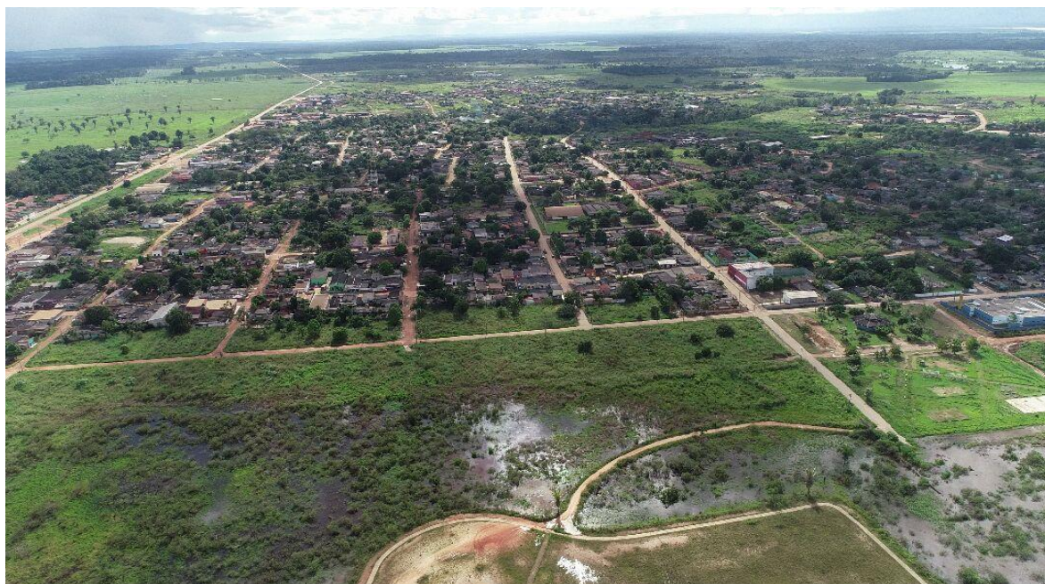
Figura 6– Alagação e encharcamento do solo no entorno do distrito de Jaci Paraná provocado pelo reservatório da UHE Santo Antônio.
