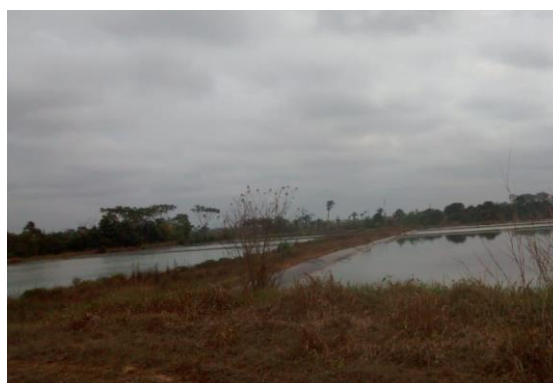
Lagoas de tratamento do chorume
