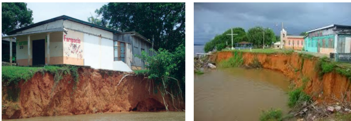
Figuras 31 e 32 – Erosão no Distrito de Calama - Vila Terra Caída
