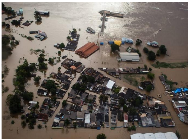
Figura 33 - Inundação em Porto Velho, ocorrida em 2014.
