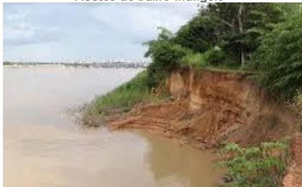
Figura 70 – Desbarrancamento do ramal Maravilha às margens do rio Madeira. Acesso ao Bairro Triângulo
