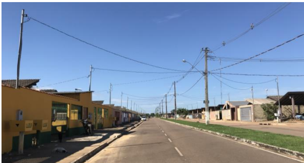
Figura 93 – Conjunto habitacional construído pelo DNIT, na ZEIS Tomé de Sousa/Balsa, na margem esquerda do rio Madeira
