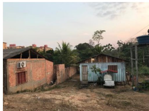
Figura 76 – Habitações precárias e sujeitas a alagamentos. Bairro Triângulo.
