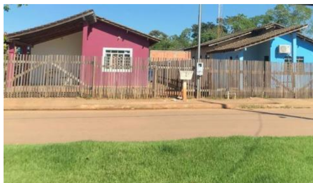
Figura 90 - Conjunto habitacional DNIT, na margem esquerda do rio Madeira
