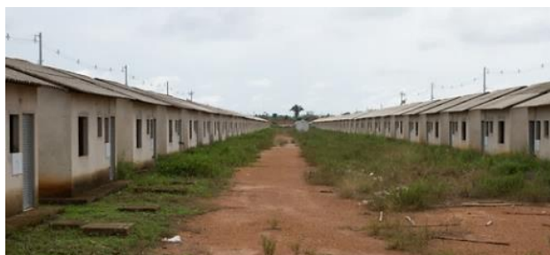
Figura 87 – obra paralisada do PAC.
